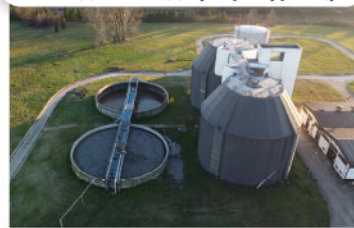
Постројење за прераду отпадних вода у Крагујевцу
