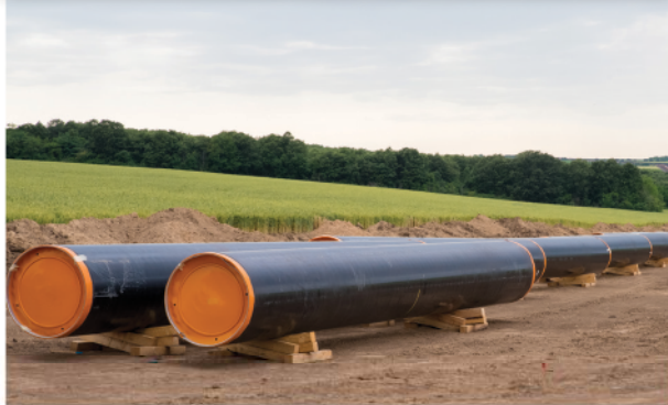
Постављање цеви за гасовод
