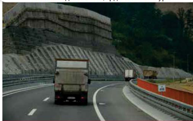
Поред саобраћајница се подижу бетонски бедеми као заштита од клизишта, Грделичка клисура
