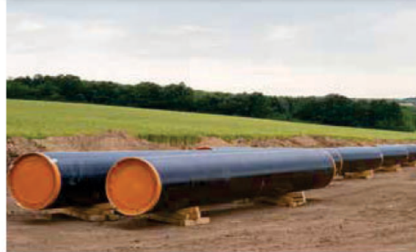
Постављање цеви за гасовод
