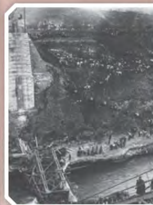
Импровизовани мост на Неретви
