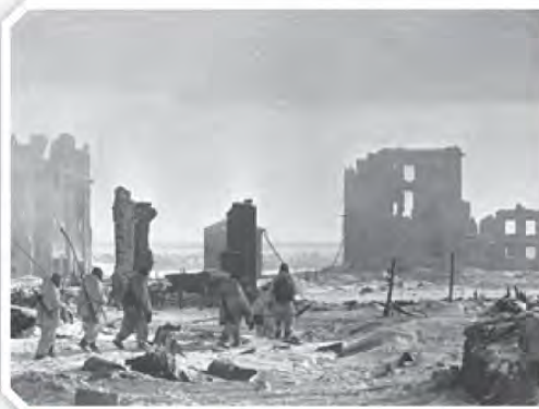
Центар Стаљинграда по окончању битке
