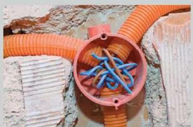
4.73 Пластична округла разводна кутија укопана у зид
