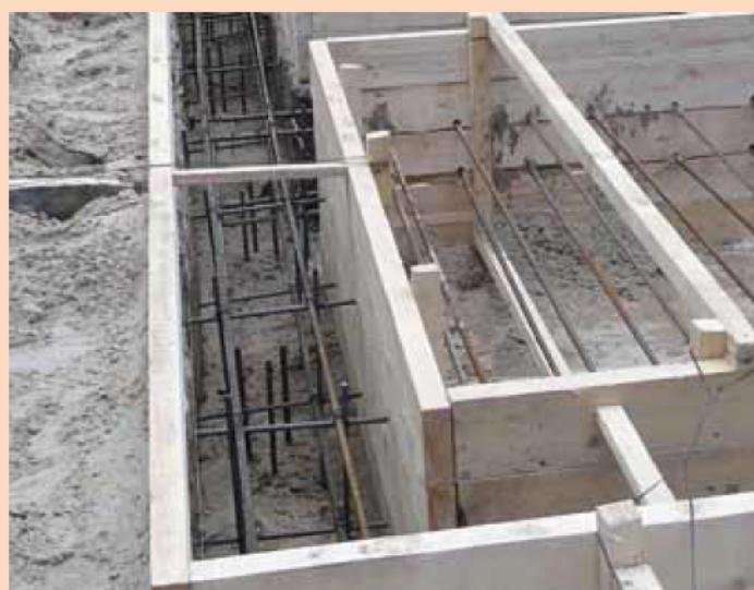
Сл. 4.13. – Опласта за изливавање бетона
