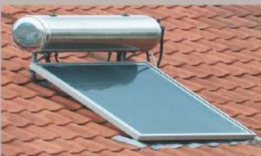
4.3 Соларна плоча за загревање воде - пример коришћења енергије Сунца за производњу топлотне енергије
