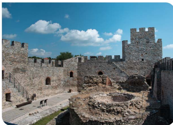
▲ Изглед унутрашњег дворишта тврђаве
