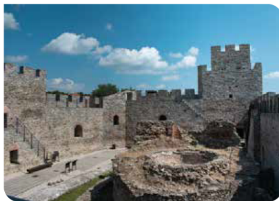
▲ Изглед унутрашњег дворишта тврђаве
