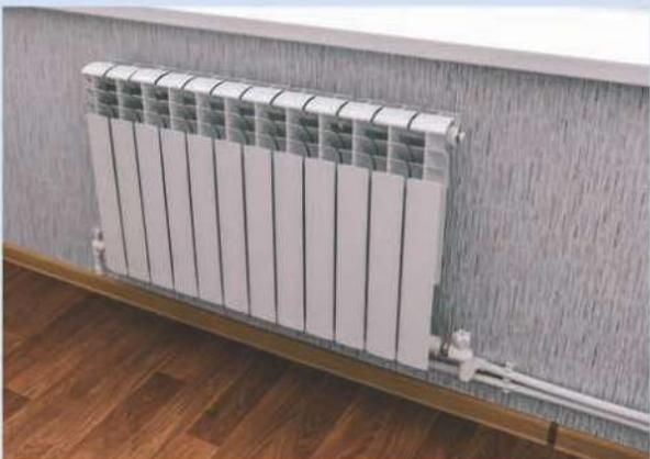
Радијатори су направљени од метала. Врела вода пролази кроз радијаторе који се загревају и топлоту даље шире. Ваздух струји кроз просторије. Топлији ваздух се креће нагоре, а хладнији надоле.
